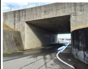
第4図 B地点のトンネル
